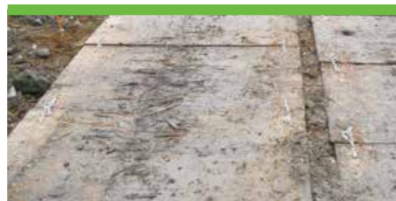
合板をチェーンで連結した状況 (車両走行による合板の移動を防止します。)
