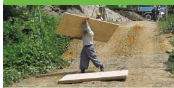
合板の運搬状況 (合板は一人でも運搬が可能です。)
