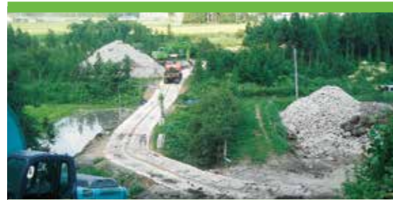
合板敷板を使用した作業道
