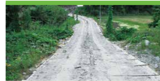
車両走行約230往復後の状態 (走行を重ねることに合板と路盤がなじんできます。)
