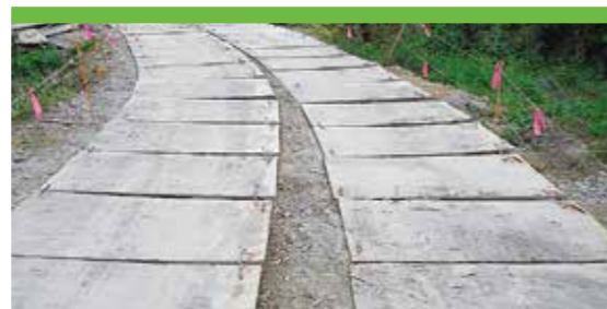
合板設置後の状況
