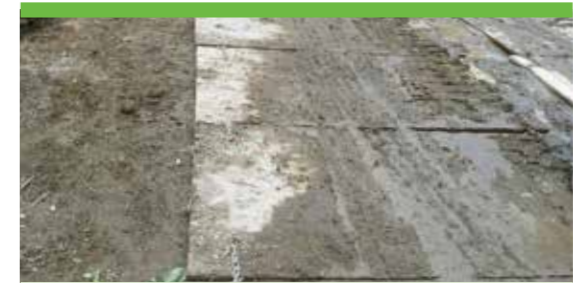
合板と路盤がなじんだ状態
