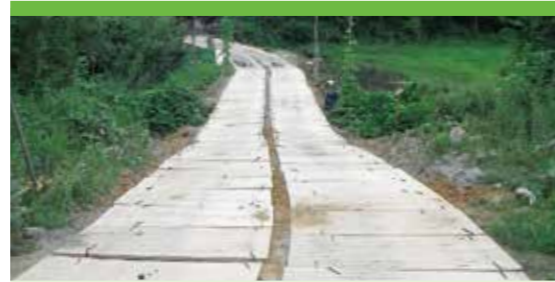
合板敷設完了の状況
